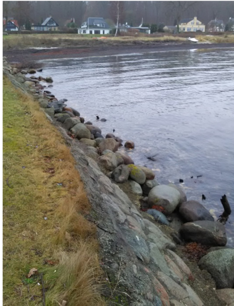
Figur 3-6 Hvor diget drejer til øst-vest gående retning er diget erosionsbeskyttet af en betonindfatning.
