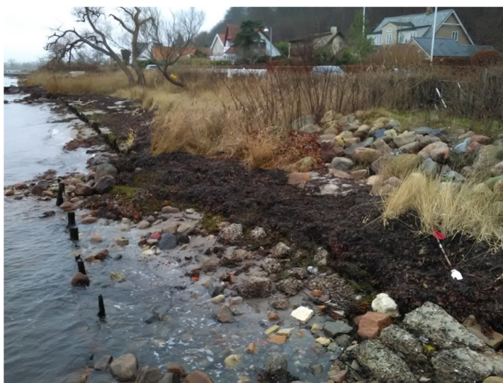
Figur 3-13 I baggrunden ses rester af pæleværk ved matr. 11ah, Dageløkke By, Humlebæk. I forgrunden ses starten af skråningsbeskyttelsen ved matr. 6af, Dageløkke By, Humlebæk.
