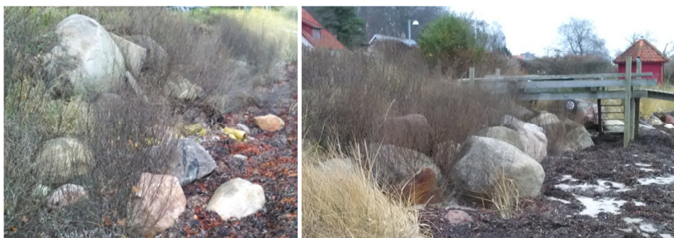
Figur 3-11 Spredte sten på op til 1 m udlagt på brinken ved matr. 11ac (tv.) og matr. 53b (th.), Dageløkke By, Humlebæk.
