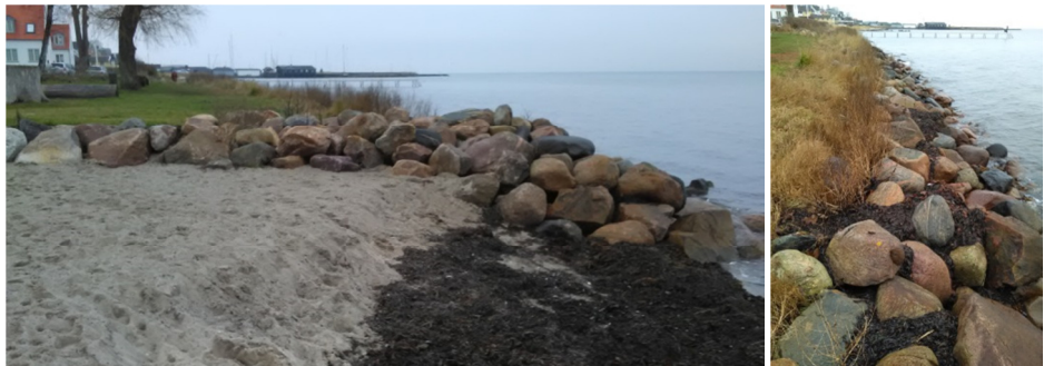
Figur 3-17 Skråningsbeskyttelse i vandlinjen ved matr. 13d, Sletten, Humlebæk.
