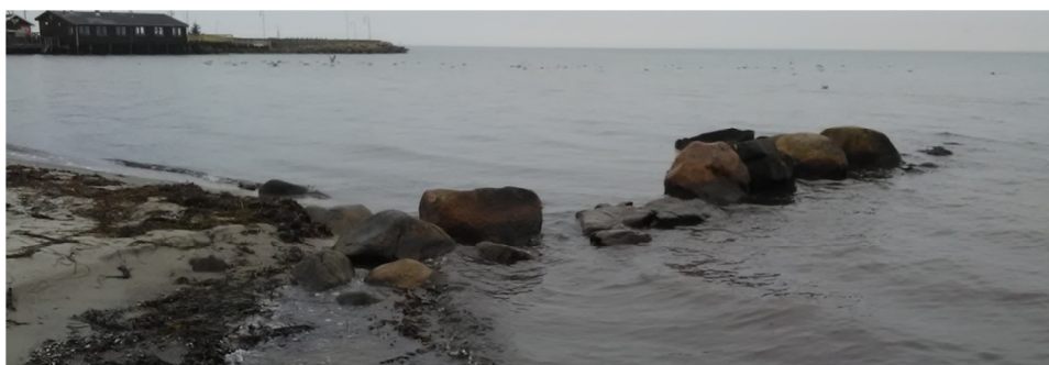
Figur 3-20 Nordligste h fde i omr de 4 best ende af sten p  ca. 80 cm. Dens store hul g r at den ydre del har minimal effekt.
