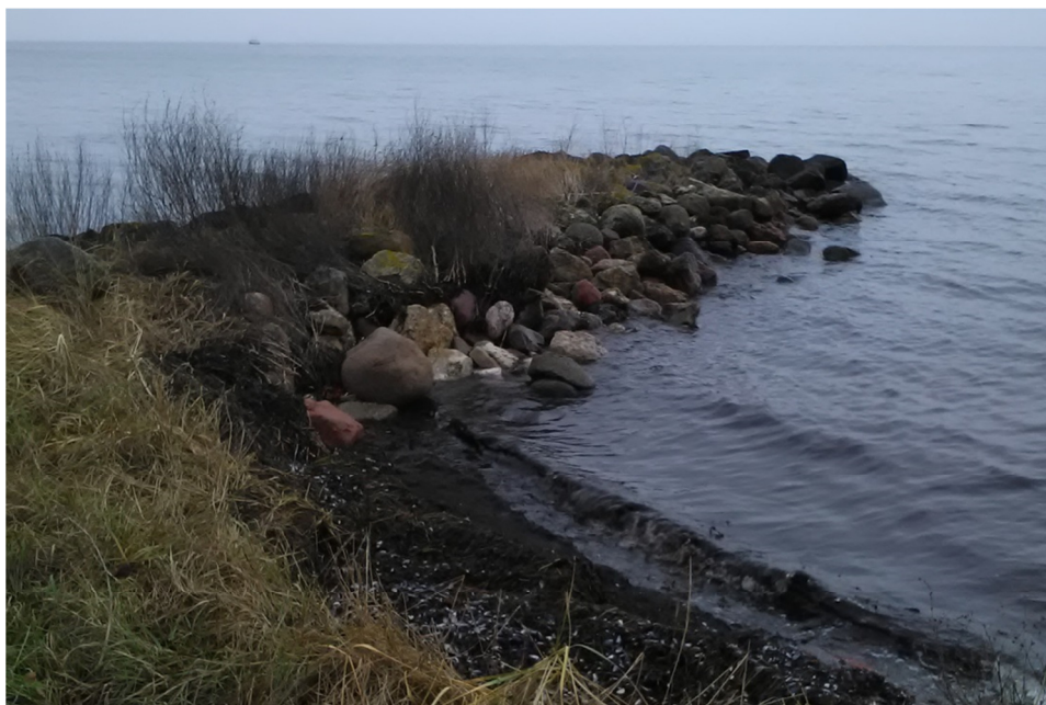
Figur 3-9 Høfde af varierende stenstørrelse ud for matr. 11ag, Dageløkke By, Humlebæk.
